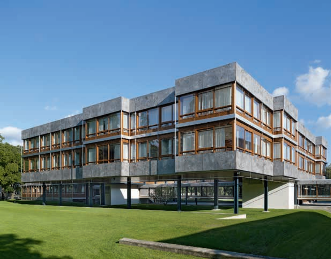
Rekonstruierte, denkmalgeschützte Fassade des Bundesverfassungsgerichts nach Schadstoffsanierung
