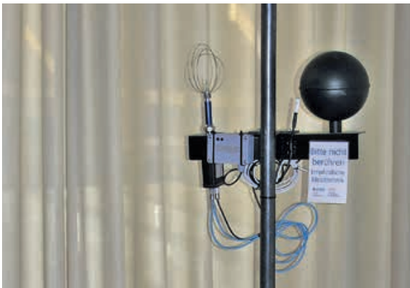
Einsatz eines Messbaums zur Bestimmung und Überprüfung der Komfortparameter im Innenraum während des Gebäudebetriebs
