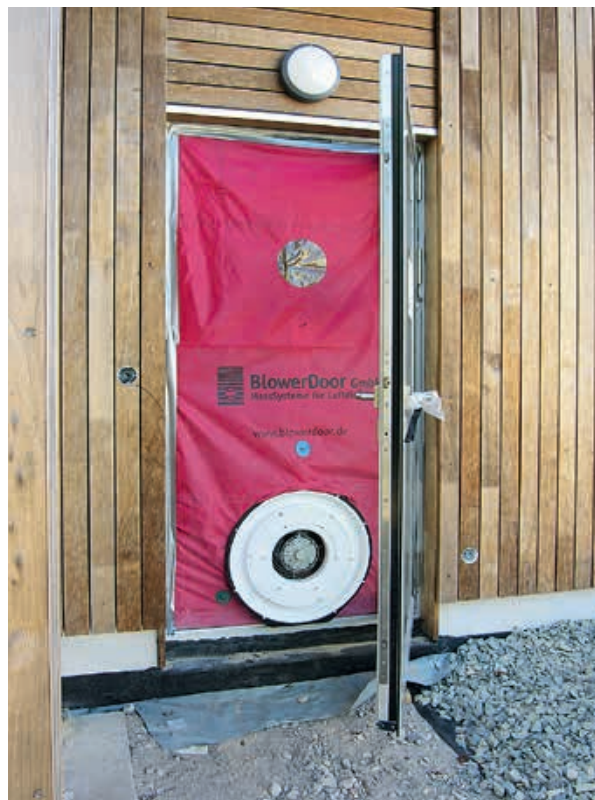
Mit dem Differenzdruck-Messverfahren wird die Luftdichtheit des Neubaus für das Umweltbundesamt Haus 2019 gemessen.
